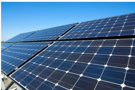
马兹穆德说，澳大利亚、美国、欧洲、中东和印度有很多大型太阳能发电设施，但是由于大多位于阳光充足的沙漠地区，干燥的气候使大量沙尘沉积在电池板表面，如果每平方米电池板上有 4 克沙尘就会使电池效率降低 40%。
