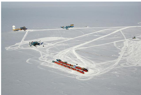
图 1 “冰立方”工程俯视照片。 图中左侧即建设中的冰立方实验室
