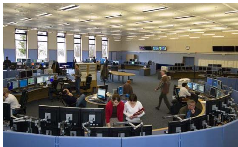
图 6 新建的 CERN 加速器控制室
