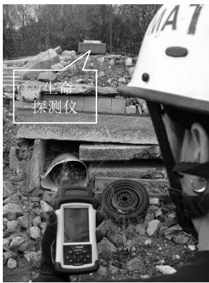
图2 用生命探测仪寻找废墟中的幸存者
