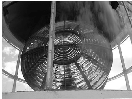
图3 现代灯塔的光源。上百万烛光亮度的电灯+菲涅尔透镜（大型的直径可达1米以上）
