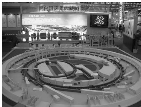
图 7 上海光源的模型。作为“发光体”的电子能量是 3.5GeV
