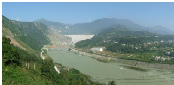
图3 紫坪铺水库大坝震后依旧巍然屹立
