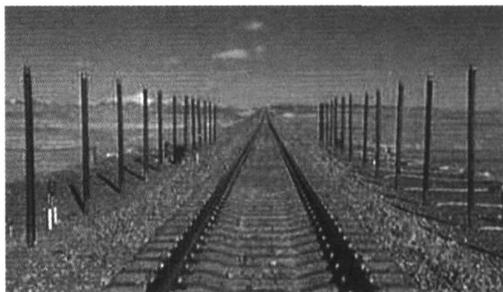
图2 青藏铁路两旁的热管
