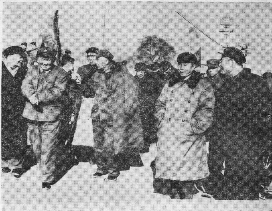
华主席、党中央决定建设我国高能物理实验中心。一声令下，建筑工人们冒着严寒，立即开进了高能加速器预制研究的施工现场，破土开工。照片是中国科学院副院长方毅等领导同志视察施工现场时的情形。
