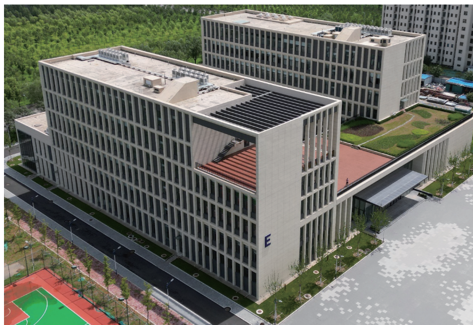
图11 国际子午圈总部大楼掠影
