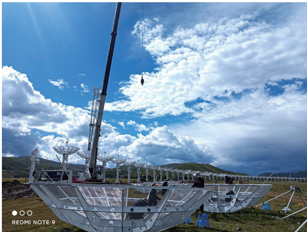
图2 建设中的“千眼天珠”(国家空间科学中心供图)
