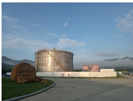
图 2 5000 m 3 烷基苯存储大罐
