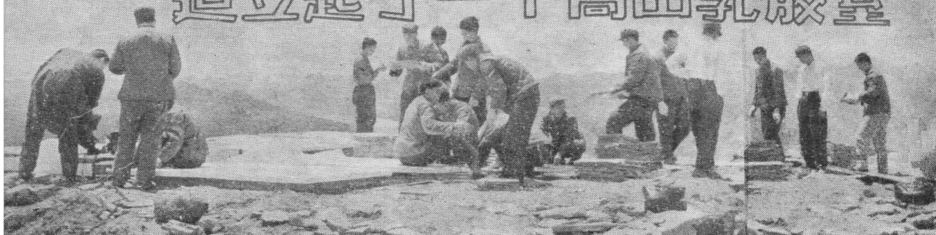
解放军和科技人员一起安装乳胶室
