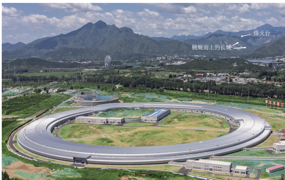
图1 建设中的HEPS。不远处的雁栖湖、沿山脊蜿蜒而上的长城和山顶的烽火台清晰可见。摄于2022年8月,HEPS工程办供稿。
