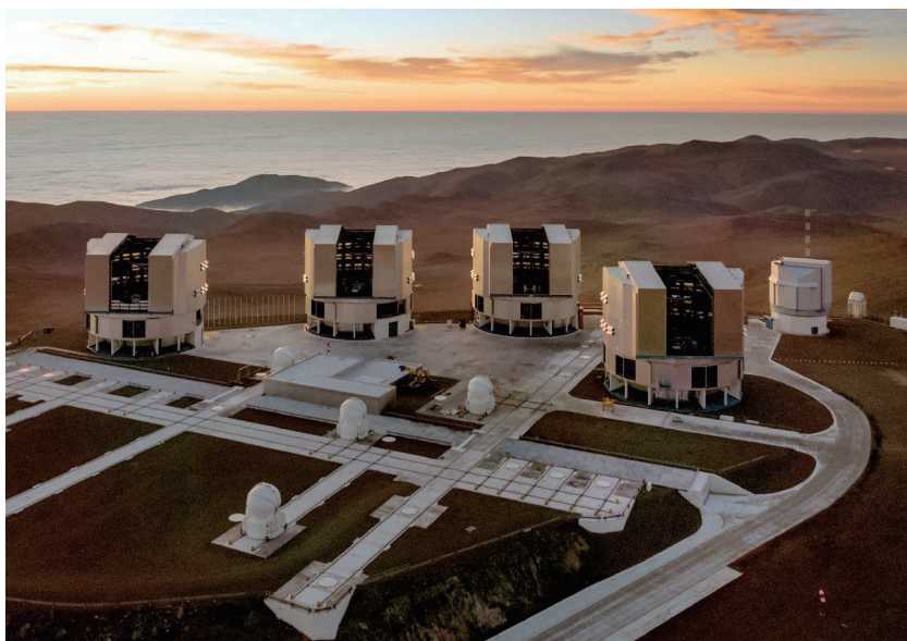
图2 欧洲南方天文台的甚大望远镜(VLT)坐落在智利北部的帕拉纳尔山顶。它由4架口径同为8.2米的反射望远镜组成,它们既可分头独立使用,也可以联合起来工作——此时其聚光能力相当于一架口径16米的反射望远镜。图中还可以看到4架口径1.8米的辅助望远镜(图片来源: https://www.eso.org/public/images/dsc4088/ )
