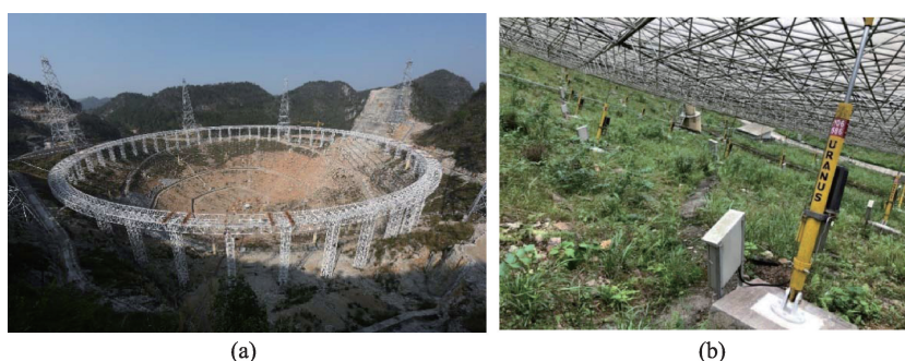
图8 FAST主动反射面系统:圈梁(a)、地锚、促动器(b)建设实景
