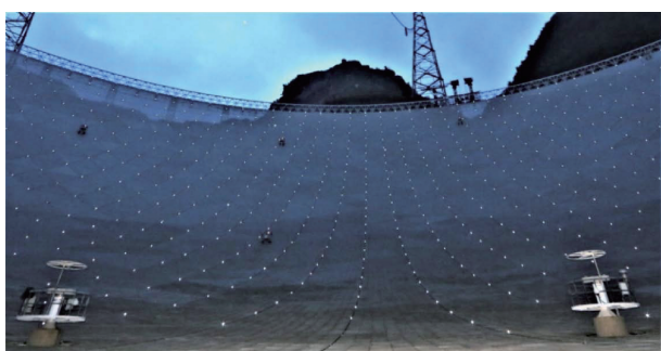
图10 夜幕下,测量基墩及分布在反射面上的靶标
