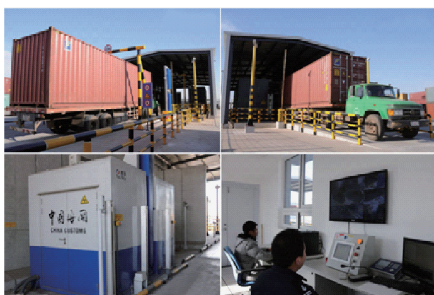
图8 安装在天津港物流中心的国产高能X射线集装箱检测系统
