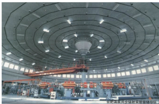
图5 合肥光源一期工程(1989年)
