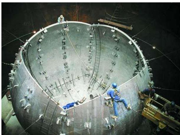
图8 正在安装的NIF装置靶室
