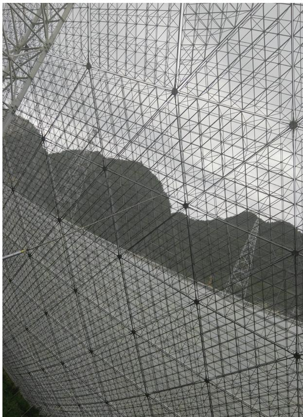
图 2 FAST 反射面背后的索网以及连接其上的促动器钢索
