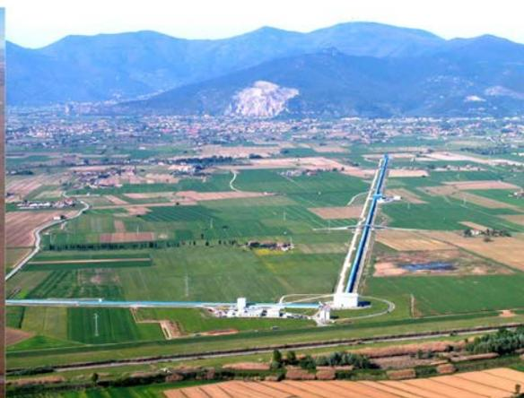
图 12 (c) 位于意大利比萨附近，由意大利和法国联合建造的臂长为 3 km 的激光干涉仪引力波探测器 VIRGO
